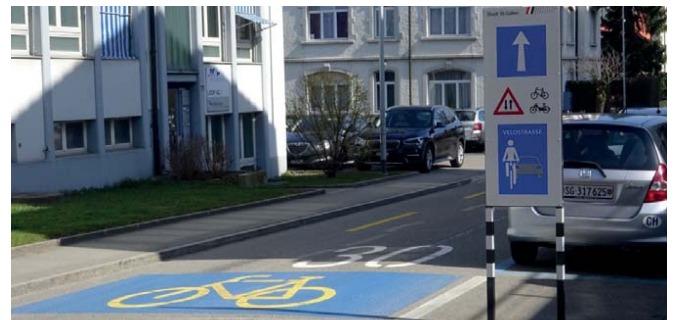
Lindenstrasse: Eingangsportal West der Velostrasse mit der neuen Signaltafel für Velostrassen und dem grossen Velopiktogramm
