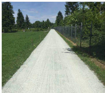
Robuster Bodenbelag "Verde Andeer": links direkt nach Einbau, rechts nach einigen Monaten (Quelle: TBA St. Gallen)
