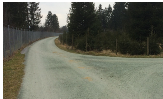
Robuster Bodenbelag "Verde Andeer": links direkt nach Einbau, rechts nach einigen Monaten (Quelle: TBA St. Gallen)
